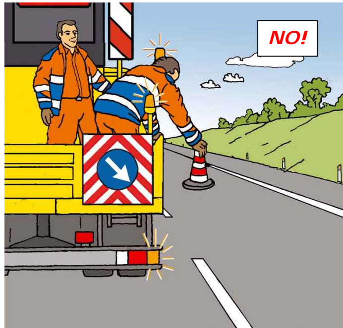
Figura 60 – Posizionamento dei coni o defleco: comportamento scorretto
