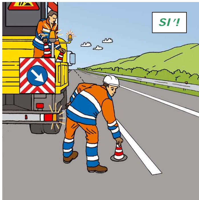
Figura 59 – Posizionamento dei coni o defleco: comportamento corretto
