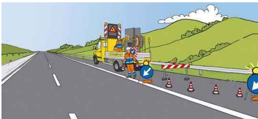
Figura 24 – Chiusura della corsia di emergenza: installazione della testata di chiusura
